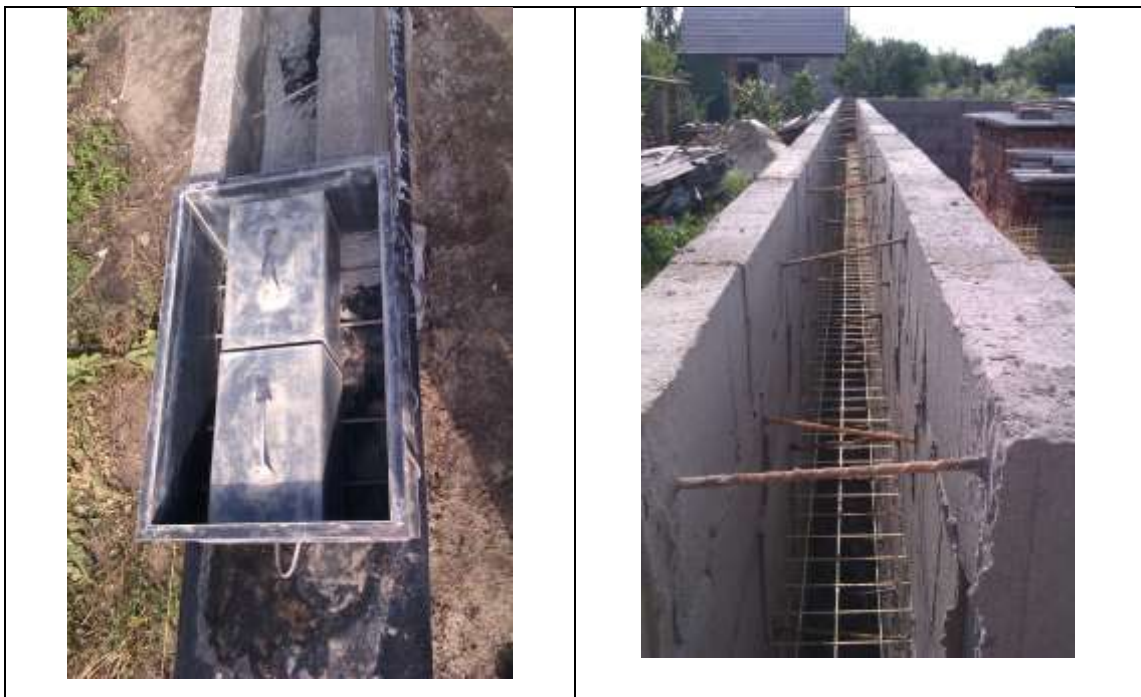
Рис. 3.3. Модуль будівництва методом ТІСЕ. Джерело: розробка автора
