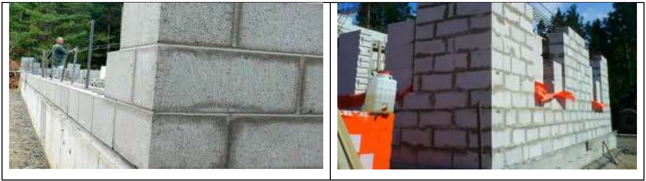
Рис. 3.4. Будівництво ТІСЕ та газоблок. Джерело: розробка автора
